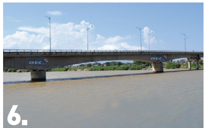
6. DỰ ÁN CẦU SÔNG LUY Luy River Project
